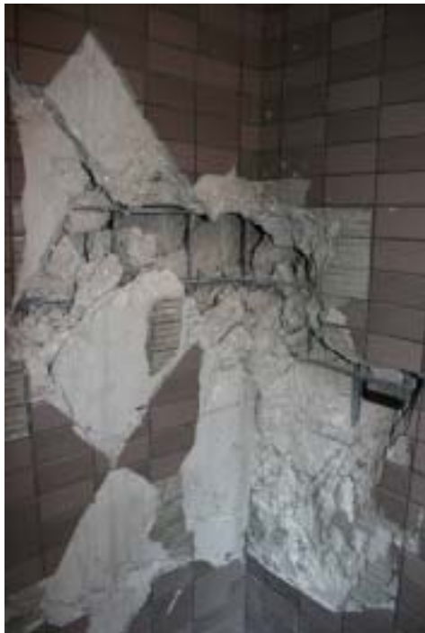
写真 2 福岡県西方沖地震で破損した非構造部材
